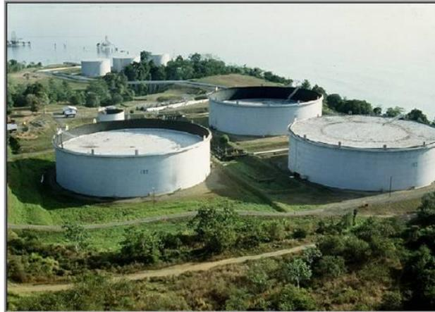
*Figura 18: Tanques con techo flotante. [49]*
